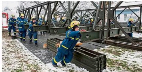
Mit vereinten Kräften schoben die ehrenamtlichen Helfer bei frostigen Temperaturen die Behelfsbrücke über die Swist.
