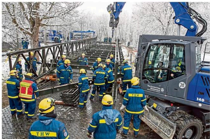
Stahlträger für Stahlträger setzten 60 ehrenamtliche Helfer des Technischen Hilfswerks die Bailey-Behelfsbrücke in der Heimerzheimer Quellenstraße zusammen.
